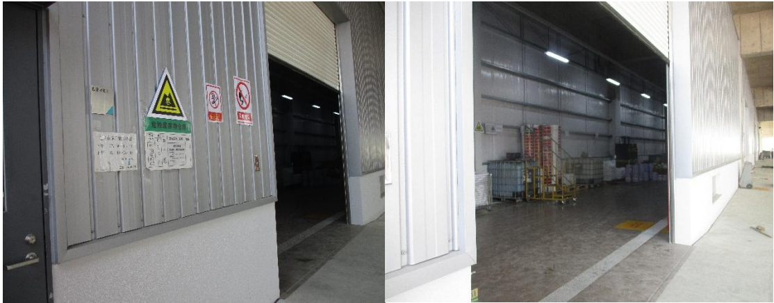
图 4.1-13 危险固废仓库照片
